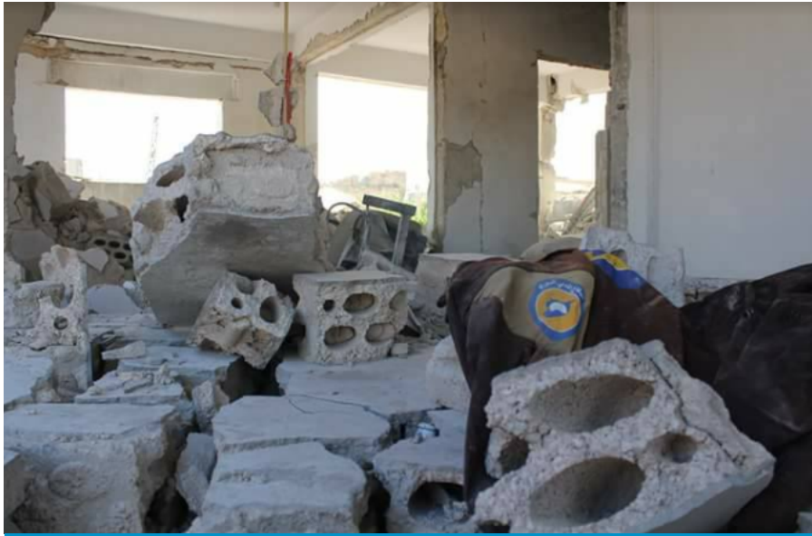
دمار إثر قصف طيران روسي بالصواريخ مبنى قيادة القطاع الشمالي التابع للدفاع المدني في مدينة كفر زيتا/ حماة 7/ 4/ 2018
