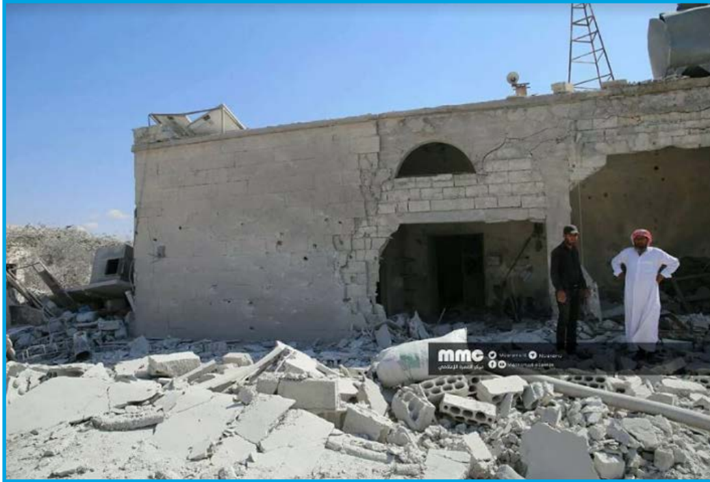
دمار في المسجد الجنوبي إثر قصف قوات النظام السوري منطقة مزرعة التسعة/ إدلب 28/ 9/ 2017
