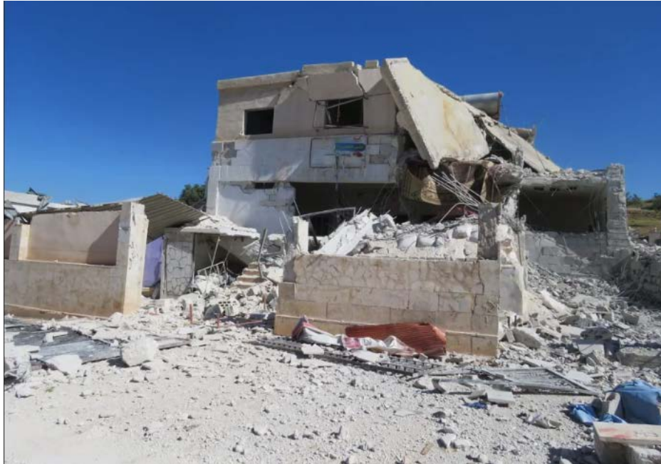
دمار لحق بمشفى ترملا التخصصي ووحدة غسيل الكلوي إثر هجوم جوي سوري - 14/ أيار/ 2019
