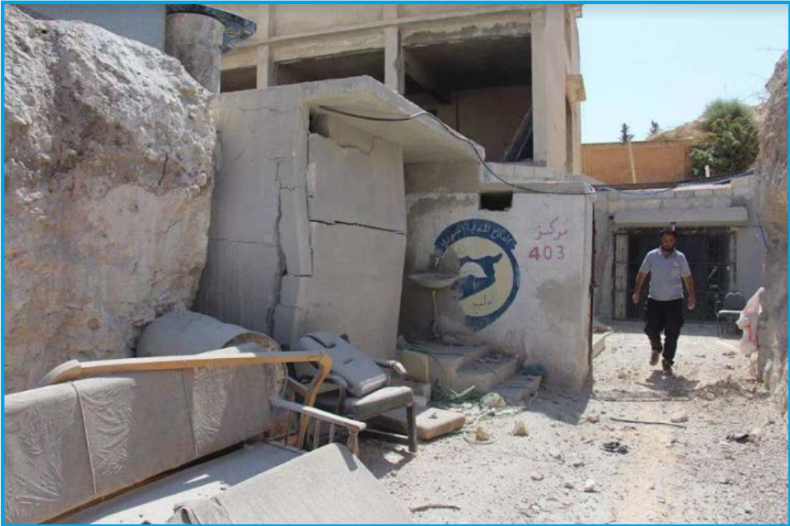
الأضرار الناجمة عن قصف قوات النظام السوري مركز الدفاع المدني في بلدة التمانعة/ إدلب 19 / 9 / 2017
