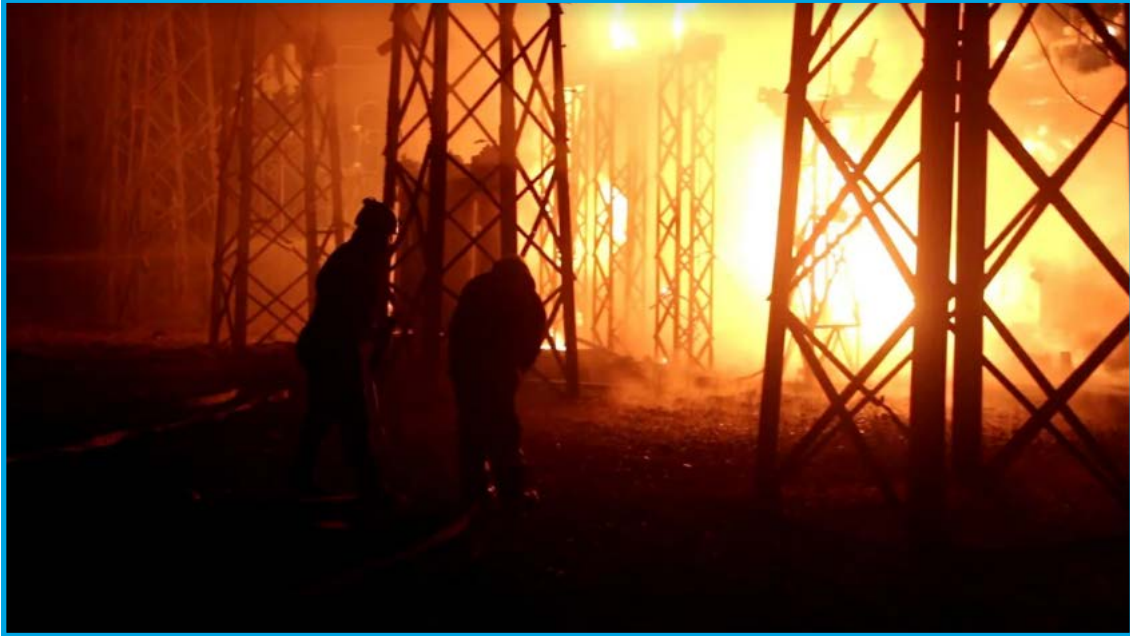
اندلاع حريق ناجم عن قصف القوات الروسية لمحطة خان شيخون لتحويل الكهرباء في قرية كفر عين/ إدلب 21 / 9 / 2017
